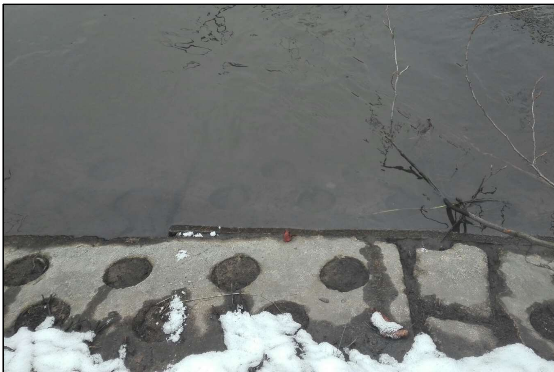
Fot. 10. Przybliżenie na umocnienie dna i lewej skarpy potoku Bobrek.
